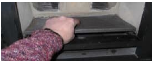
5. Gussrost entfernen
