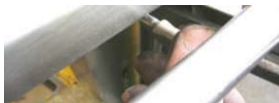
9. Den Knauf der Anheizklappe heraus-schrauben.
