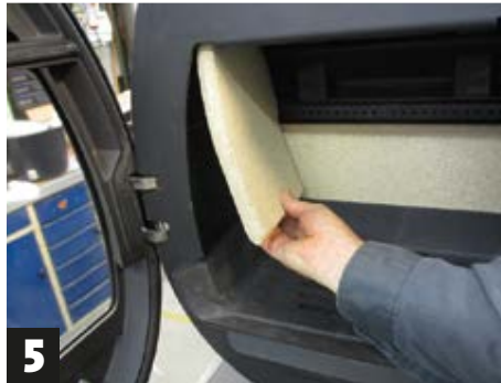
5 Seitenplatte oben anpassen
