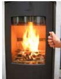
5. Sind die unter Punkt 4 genannten Voraussetzungen erfüllt, verteilen Sie auf der Glut in einer Schicht max. 3 Holzscheite mit einem Gesamtgewicht von 1,5-2,5 kg, bzw. 25-30 cm Länge, unter Einhaltung von ca. 1 cm großen Abständen.
