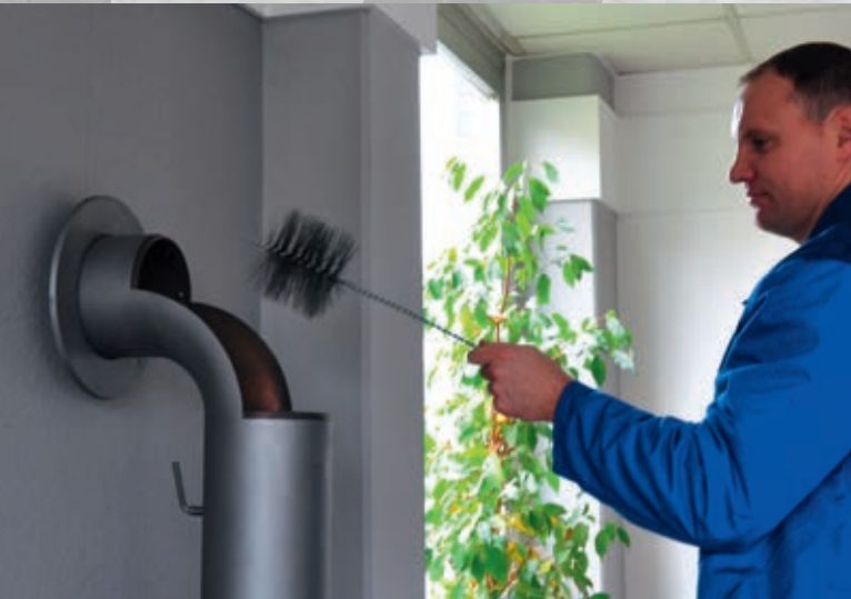
Kehren des Rauchrohrs
