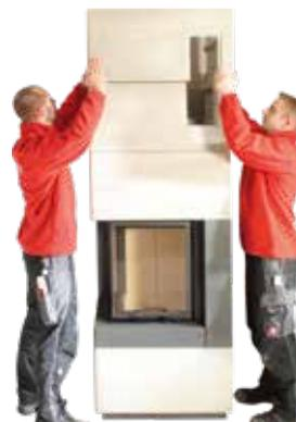
9. Nur bei Ausführung S9 Hoch: Zweites und drittes Haubenteil (mit Ausschnitte für Lüftungsgitter) **ohne zu Verkleben** auf das Erste setzen.
