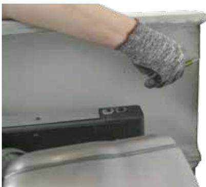
10. Anlage jetzt zurückbauen und für die rückseitige Dämmung (8 cm) die Innenkonturen an der Wand markieren.
