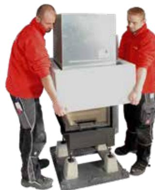
4. Unterteil von oben auf die Bodenplatte setzen...
