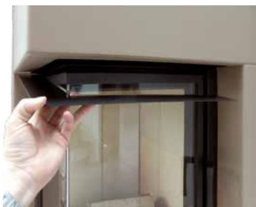
18. Nur bei Ausführung Kamineinsatz mit schwenkbarer Tür: Haubenbedeckung auf den Einsatz positionieren.
