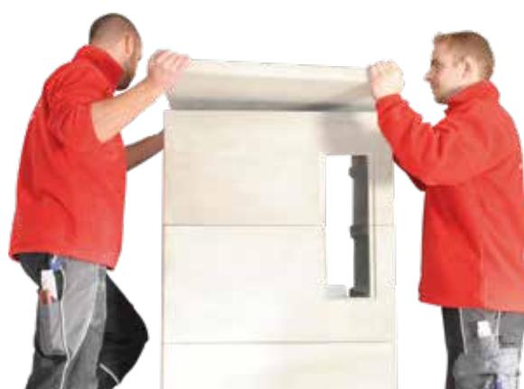
15. Nur bei Ausführung S9 Hoch: Alle Teile mit Acrylkleber neu setzen. Zwischendecke auf die vorhandenen Auflageflächen im dritten Haubenteil legen...
