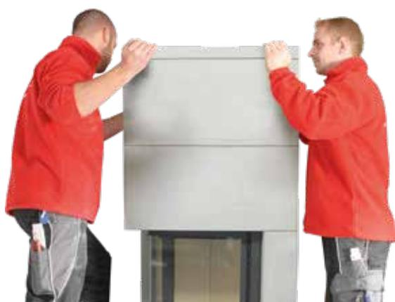
14. Nur bei Ausführung S9 Kurz und Maxi: Alle Teile mit Acrylkleber neu setzen. Deckplatte mit Ausschnitt auf das Oberteil legen und ausrichten.
