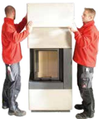
8. Nur bei Ausführung S9 Kurz und Maxi: Zweites Haubenteil (ohne Ausschnitte für Lüftungsgitter) **ohne zu Verkleben** auf das Erste setzen.
