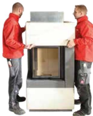
7. Erstes Haubenteil **ohne zu Verkleben** auf die Seitenteile setzen und mit Wasserwaage ausrichten.
