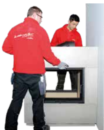
10. Oberteil ohne zu verkleben vorsichtig auf die Seitenteile setzen und ausrichten.
