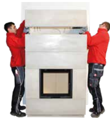
13. Haubenteil ohne zu verkleben auf das Oberteil (bei S7 Kurz!) / Mittelteil (bei S7 Hoch!) setzen.
