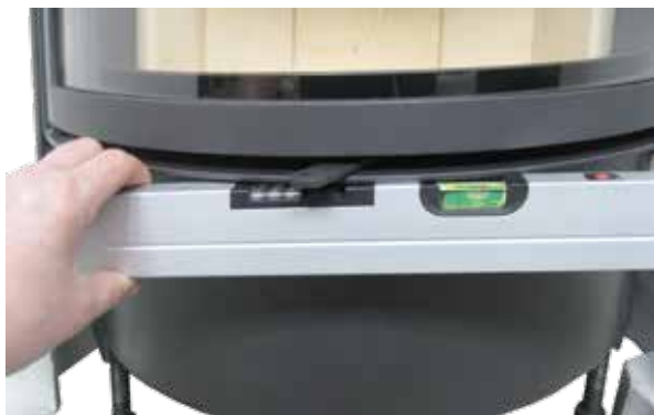
3. ... und mit Wasserwaage ausrichten.
