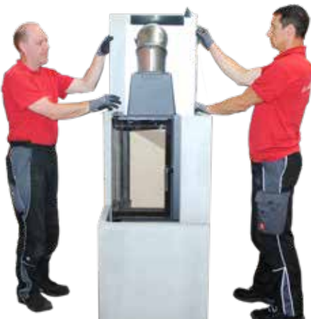
17. Obere Rückwand (wie in Pkt. 5 beschrieben) auf das Seitenteil (mit integrierter Hinterlüftung) setzen. Die Rückwand ist beschriftet für Aufbauversion links oder rechts.
