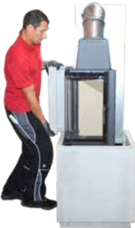
15. Seitenteil (mit integrierter Hinterlüftung) ohne zu verkleben von oben mit der Sichtseite außen bündig auf das Unterteil setzen! Hinterlüftung zur Wandseite!
