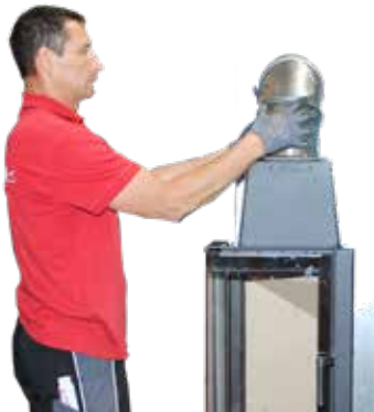
13. Abgasbogen 160'er für waagerechten Anschluss auf den Abgasstutzen montieren.
