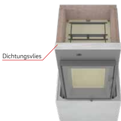
13. Innenauskleidung vorsichtig wieder einsetzen und vorderes Dichtungsvlies auflegen.
