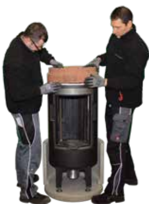
19. Oberen Schamottering auflegen.
