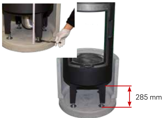
15. ... und mit Hilfe der Verstellerschrauben von Oberkante Bodenplatte aus bis Unterkante Korpus auf eine Höhe von 285 mm einstellen.
