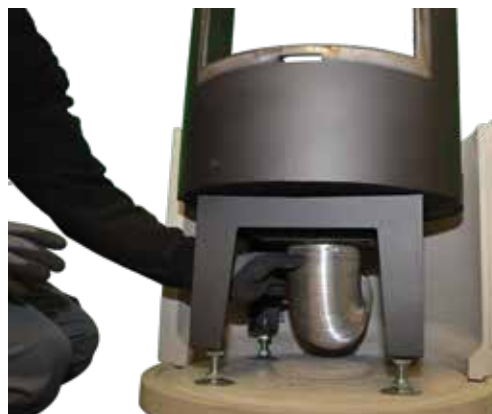
16. Die Verbrennungsluft zuführung (Flexschlauch Ø 125 mm) mit Schnellspannschelle am unteren Stutzen montieren.
