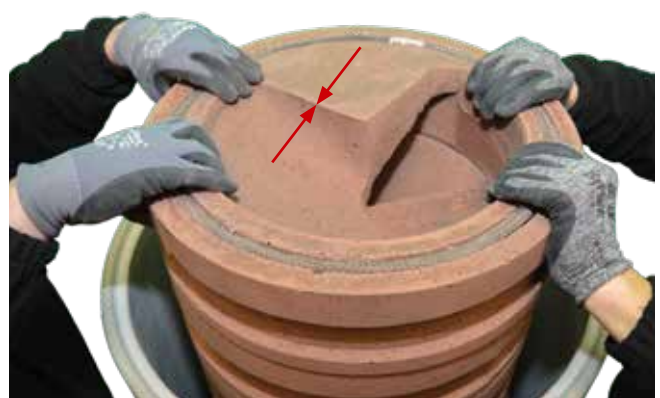
33. Vierten Schamottering auflegen und Drehzugrichtung durch Verdrehen einstellen. Die Kantenlinien der Übergänge (innen) müssen übereinander liegen. (siehe Pfeil).
