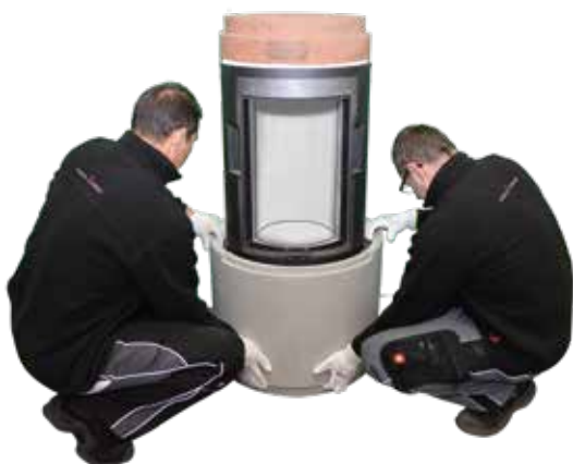
21. Vorderes Unterbauteil ohne zu verkleben auf die Bodenplatte setzen.
