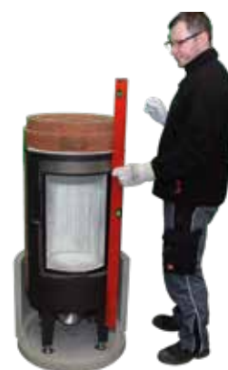
20. Grundofenkorpus mit Wasserwaage ausrichten und ggf. nachstellen.
