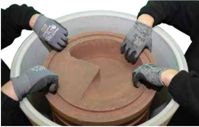
30. Jetzt den zweiten Schamottering gleichmäßig auflegen...
