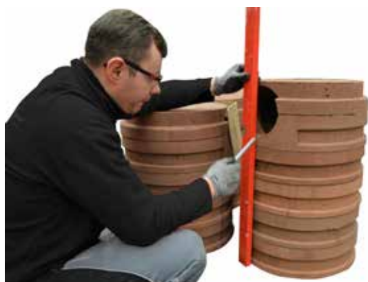
25. Mit der Wasserwaage Mittig am Anschluss eine senkrechte Montagehilfslinie zeichnen ( nur bei Wandanschluss ).
