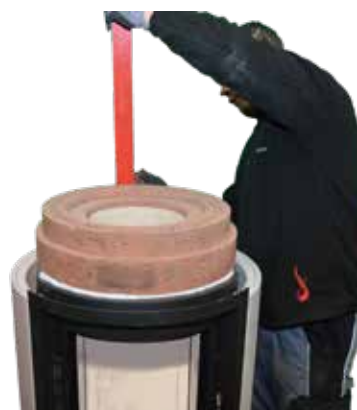
26. Anschließend eine Montagehilfslinie mittig an der Rückseite vom oberen Schamottering anzeichnen. ( Nur bei Wandanschluss ).
