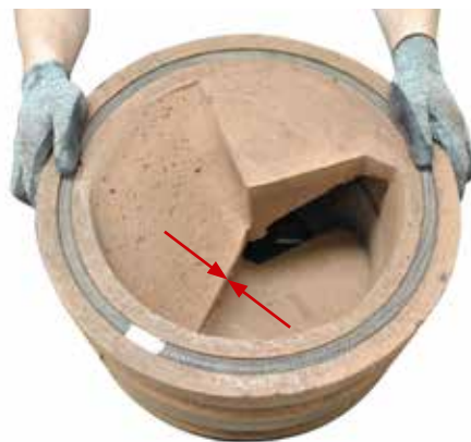
24. Vor der Drehzugmontage den Drehzug bereits auf der Palette durch Verdrehen einstellen ( nur bei Wandanschluss ). Die Kantenlinie der Übergänge muss übereinander liegen (siehe Pfeil)
