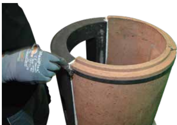
17. Schamotteaussenhülle mit Dichtungsvlies einsetzen und den Schamottehaltering wieder montieren.
