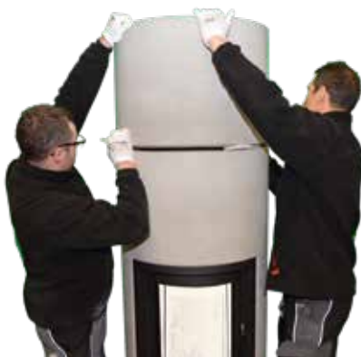
34. Zur Montageerleichterung bitte die Verpackungsstreifen erneut auf allen vier Ecken auflegen und das Haubenteil ohne zu verkleben setzen (dann die Montageerleichterung wieder entfernen).
