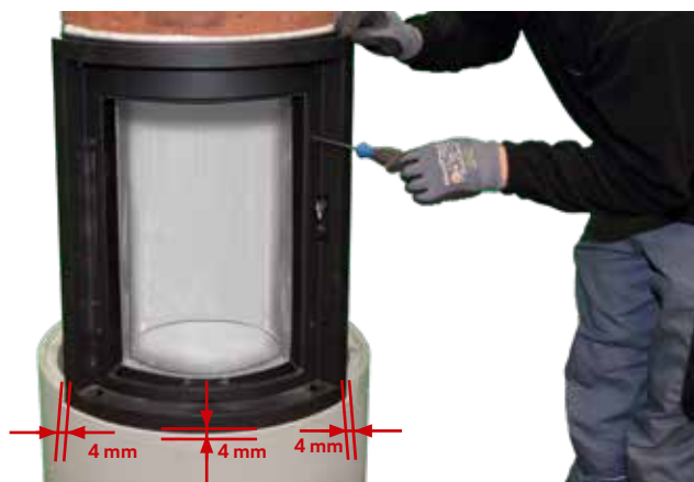
22. Tüorzarge wieder an vorgegebener Position mit Schraube M 6 x 10 montieren und Korpus gleichmäßig ausrichten.
