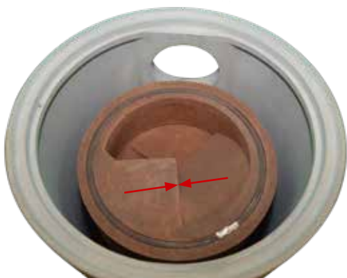
46. Fünften Schamottering auflegen und Drehzugrichtung durch Verdrehen einstellen.
