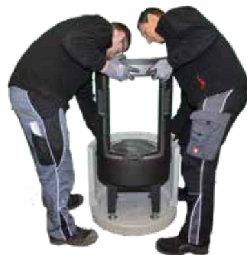
14. Ronda GO Korpus auf die vorgesehenen Positionen der Bodenplatte setzen...
