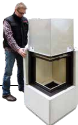
13. Seitenteile rechts und links ohne zu Verkleben setzen.
