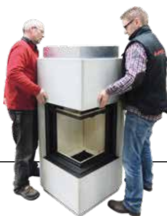
15. Haubenaufsatzteil ohne zu Verkleben auf die Seitenteile setzen.
