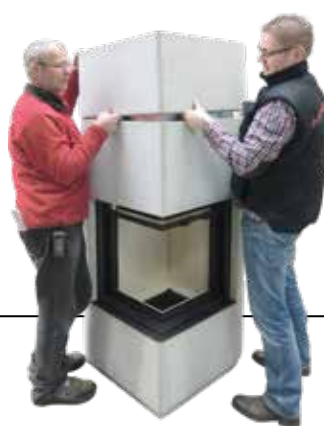
16. Haubenoberteil ohne zu Verkleben setzen.
