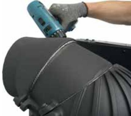
1. Abgaskuppel für waagerechten oder senkrechten Anschluss montieren.
