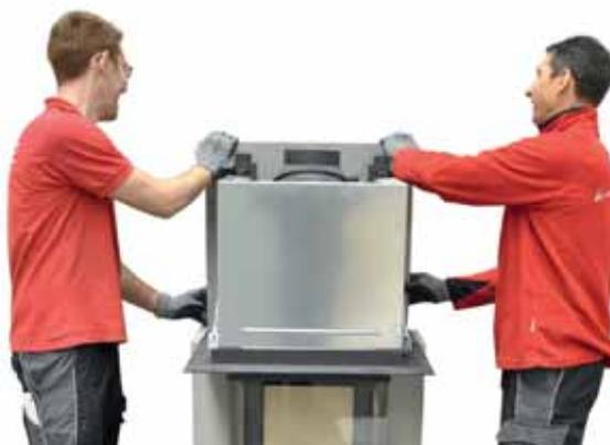
7. Mittlere Rückwand (Hinterlüftung zur Wand ausrichten) auf das Seitenteil (mit integrierter Hinterlüftung) setzen.
