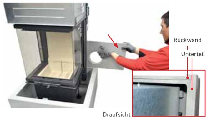
4. Rückwandmodul Höhe 309 mm mit Hinterlüftung und seitlichen Lufteinlässen nach unten **ohne zu verkleben** auf die Bodenplatte bzw. auf das zweite Unterbauteil setzen. Hinterlüftung zur Wandseite!
