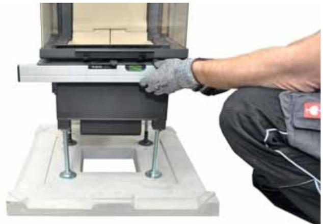
10. Kamineinsatz mit Wasserwaage ausrichten.
