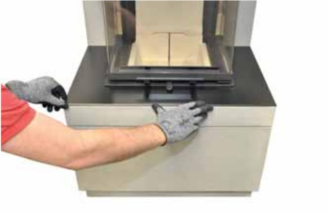
16. Bankplatte aus Stahl auf die Bank setzen, unter die Traverse schieben und ausrichten.
