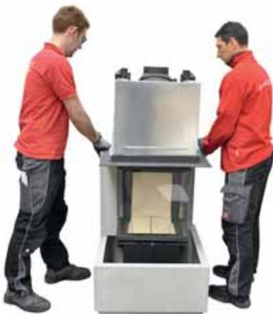
5. Tragrahmen wieder montieren und das Seitenteil (mit integrierter Hinterlüftung) **ohne zu verkleben** von oben, mit der Sichtseite außen bündig auf das Unterbauteil setzen. Hinterlüftung zur Wandseite!
