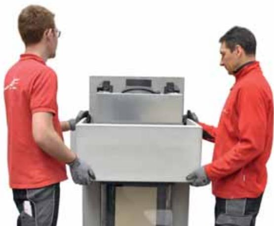
8. Erstes Oberbauteil **ohne zu Verkleben** mit der Falzseite von oben auf den Tragrahmen setzen und ausrichten. Tragrahmen ggf. nachstellen.
