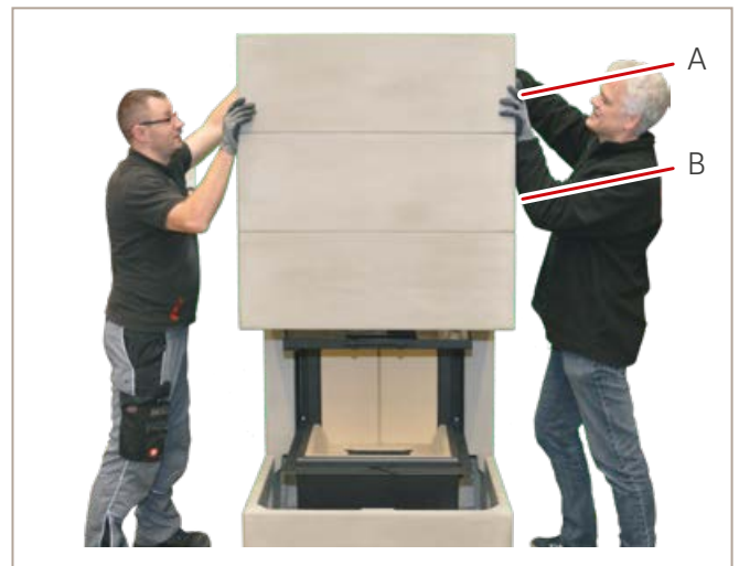
Abb. 47: Oberbauteil 3 setzen
