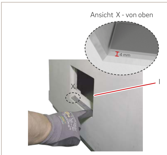
Abb. 49: Revision Dichtungsband 140 mm unten einkleben
