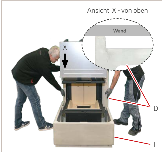
Abb. 40: Seitenteil lang setzen
