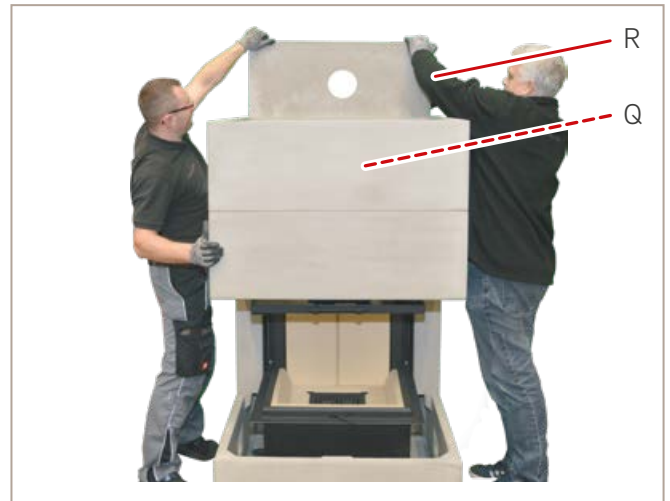
Abb. 46: Rückwand 3 setzen
