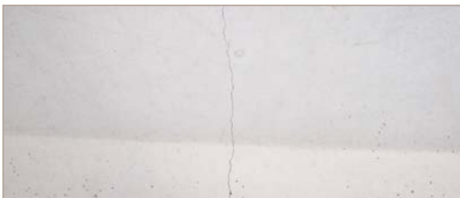
Abb. 72: Beispiel oberflächlicher Riss
