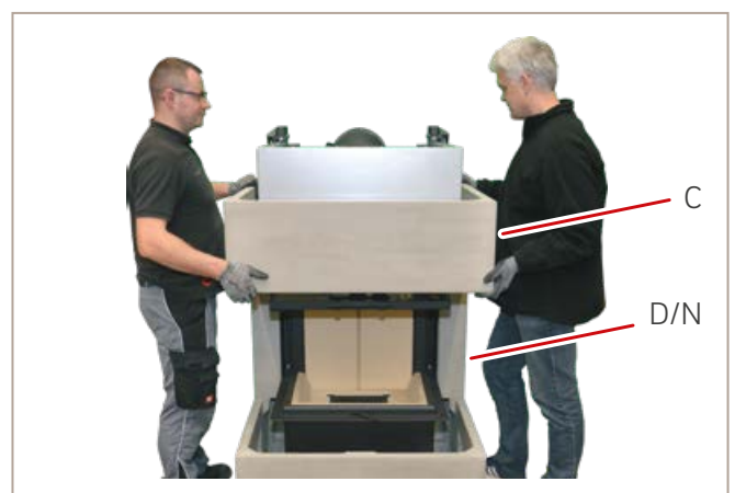
Abb. 43: Oberbauteil 1 setzen
