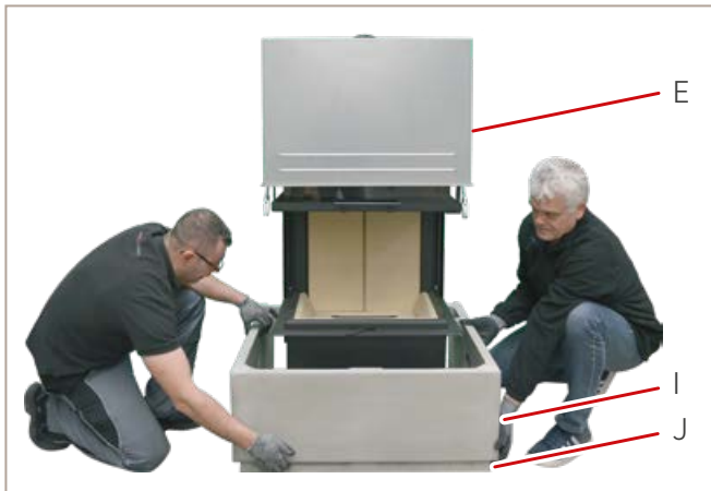
Abb. 37: Unterbauteil setzen
