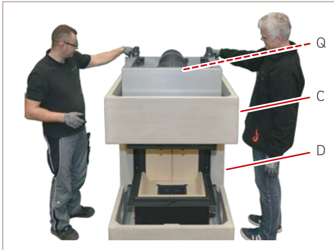
Abb. 44: Rückwand 2 setzen
