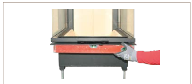
Abb. 30: Kamineinsatz positionieren und mit Wasserwaage ausrichten
