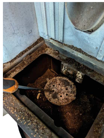
Fig. 42 - Reinigung Brennschale
