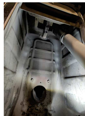
Fig. 82 - Die Asche absaugen
