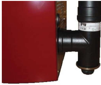
Fig. 73 - Reinigung des Rauchgaskanals
