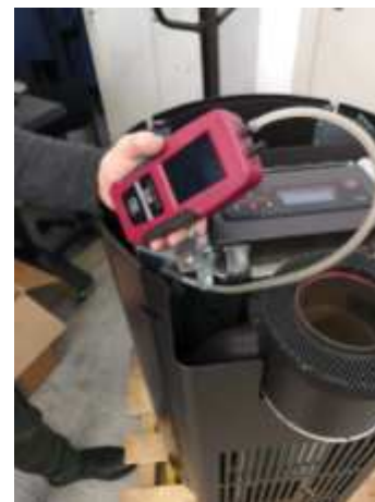
Fig. 72 - Anschluss des Digitaldruckwächters 2
