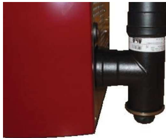
Fig. 25 - Reinigung des Rauchgaskanals
