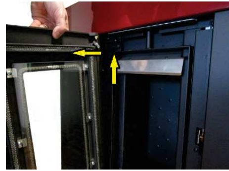
Fig. 14 - Ausbau der Tür
